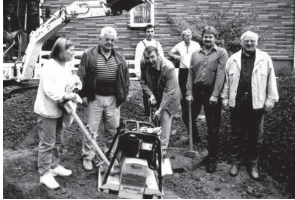
Bildmitte: Der stellvertretende Ortsbürgermeister Gerhard Mundt setzt den ersten Spatenstich für den neuen Dorfplatz.
