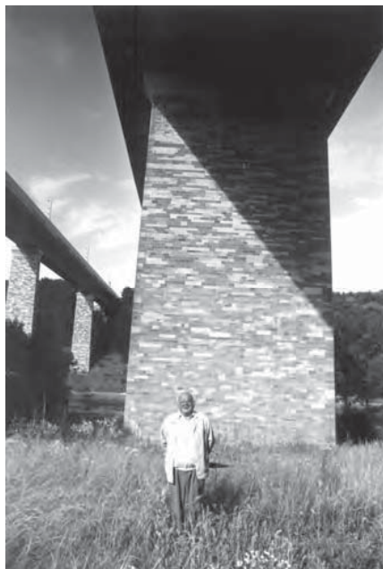
Bruno Sboron an der Unfallstelle unter der neu erbauten Autobahnbrücke.
